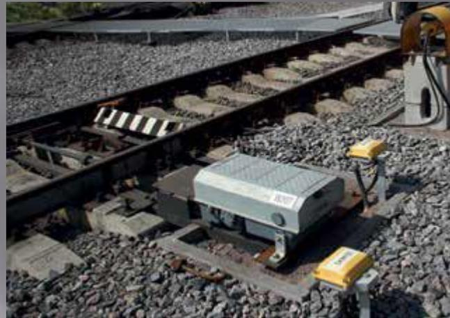
Электропривода S700 – без контрольных линеек с двигателями переменного тока. Усилие фрикционного механизма с высокой точностью настроено и опломбировано производителем в заводских условиях, что уменьшает список требуемых работ по ТО
