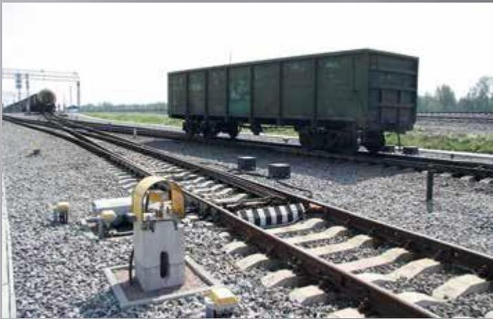
Радары Tempomat Rh - определяют длину отцепы и скорость входа и выхода отцепов из тормозных позиций
